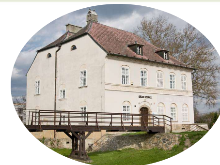
Statické zajištění, rekonstrukce střechy a výměna krovu měšťanského domu č.p. 480
