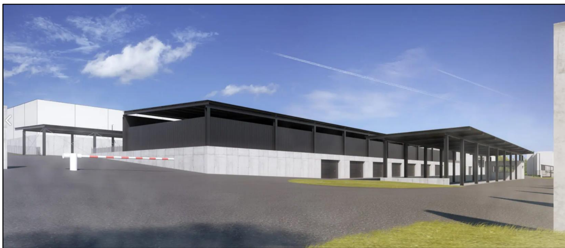
Obr. 3: Modernizované odpadové centrum v Hranicích.
