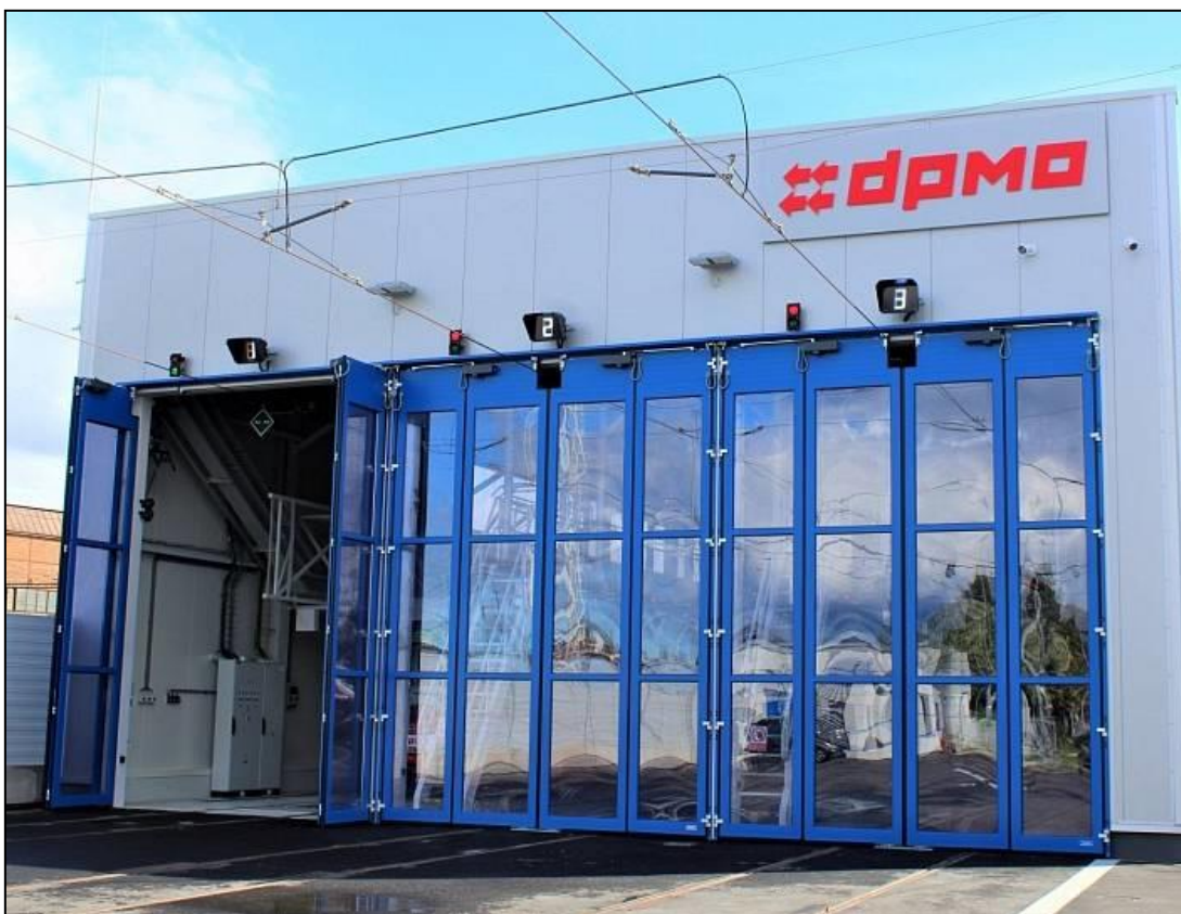
Obr. 3: Nové depo pro odstavování tramvají.
