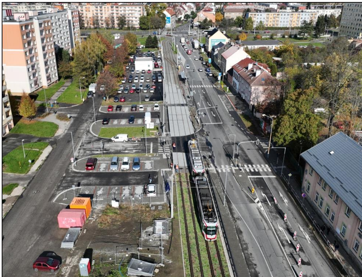
Obr. 1: Jeden z úseků nové tramvajové tratě.
